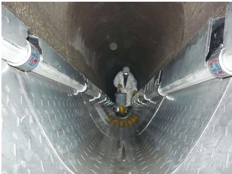
Bild 1: So sieht der fertig verlegte Wärmetauscher im Abwasserkanal aus. (hochaufgelöstes Foto hier )
