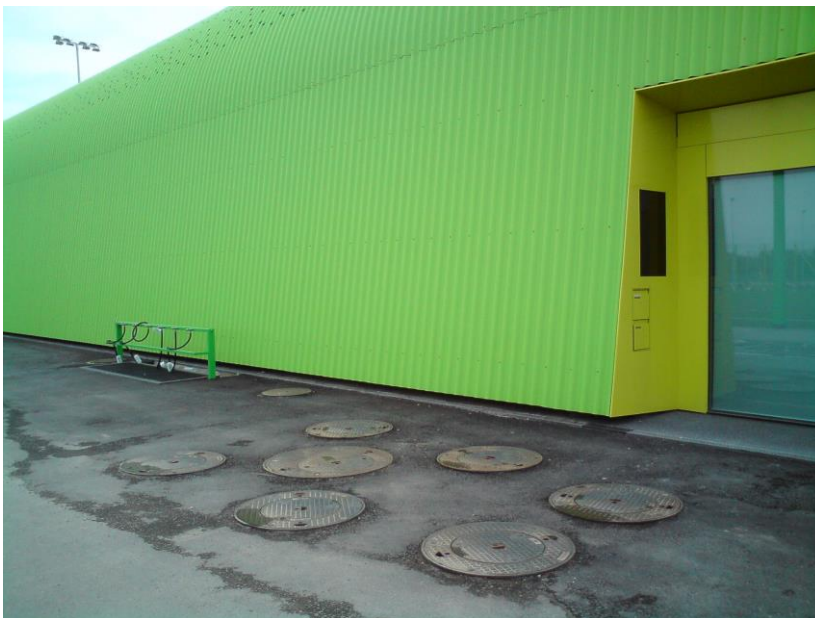
Abbildung 8: Außenansicht der Sportanlage Heerenschürli; unter den 7 Deckeln befindet sich das Abwassersammelbecken zur Wärmeentnahme
