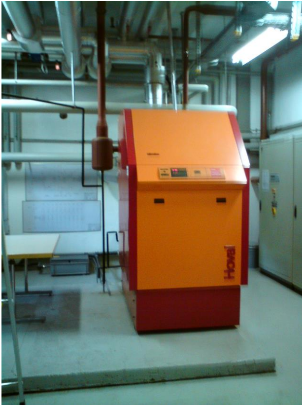
Abbildung 7: Gaskessel zur Spitzenlastabdeckung
