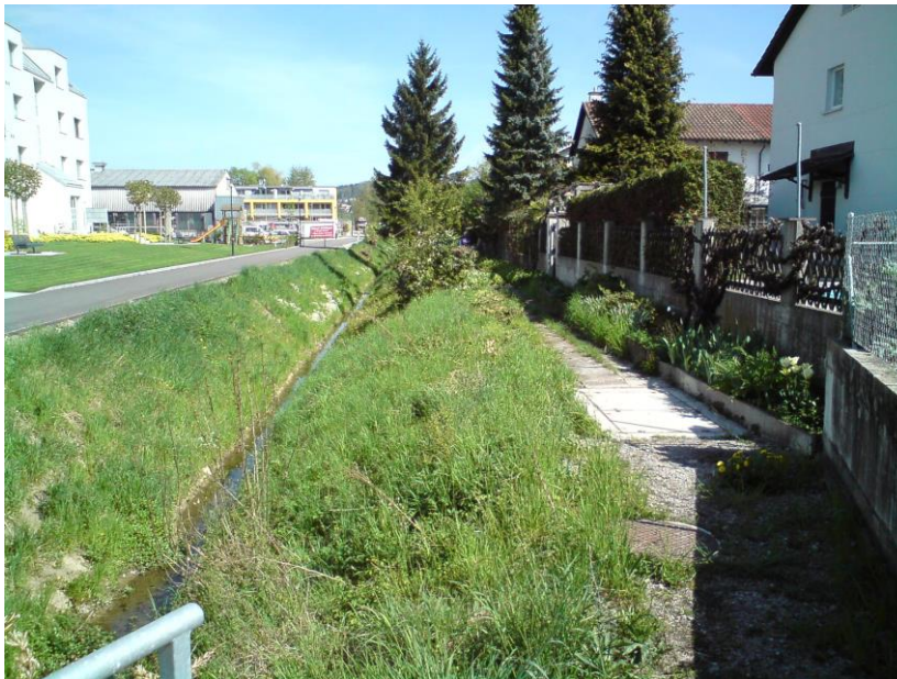
Abbildung 3: Kanalenschacht (rechts) und Kanaltrasse; ganz links ist eines der von der Anlage versorgten Gebäude zu erkennen
